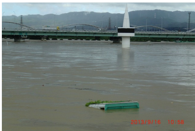
平成25年9月台風18号出水状況（枚方）
