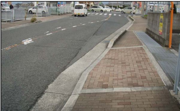
写真-1 右折レーンと歩道幅員が暫定整備 (現状)
