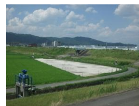
写真-2 小田遊水池周囲堤
