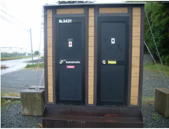
図-10 現場に設置された男女別トイレ
