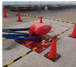
写真-2 取外し式係船柱
