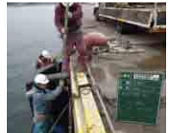
写真-3 高性能防舷材の設置
