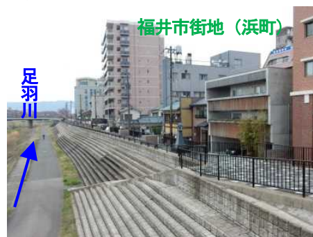
〈写真-1 足羽川（幸橋付近）〉
