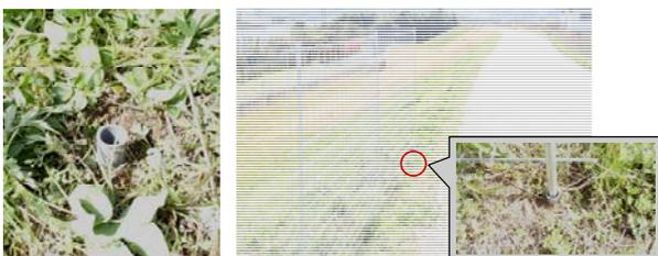
図 6.2 VP管による柵設置の簡易化
