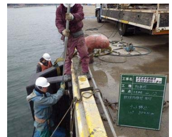
写真-3 高性能防舷材の設置
