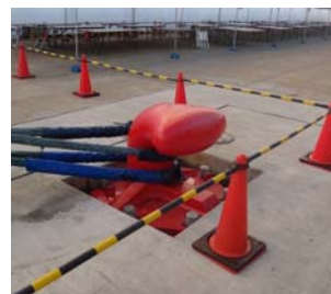
写真-2 取外し式係船柱
