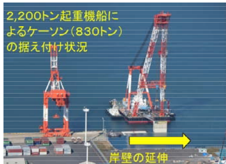
図-10 岸壁の延長状況
