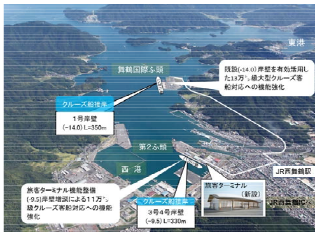
図-3 大型クルーズ船に対応した国際ふ頭、第2ふ頭
