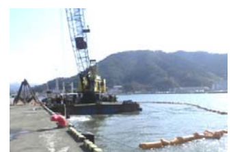
写真-4 薄層浚渫の実施
