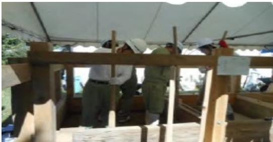
写真5-4-1 版築搗き作業状況
