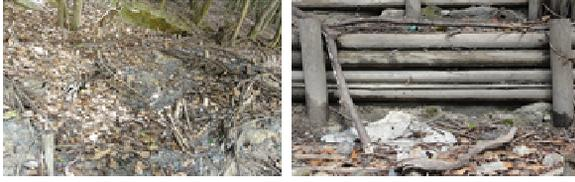
土壤浸食状況（柳枝が破損） 木柵基礎端部土砂の流出状況
