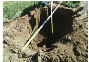
写真-6 陥没箇所b試掘状況
