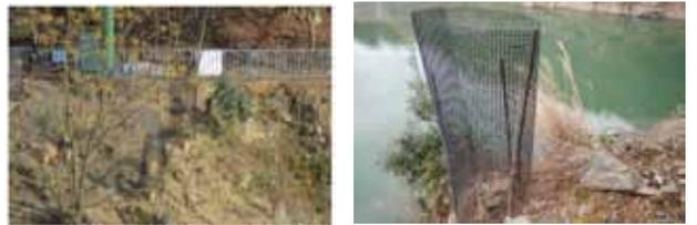
写真-8 金網柵工の代替 (ミキガード)
