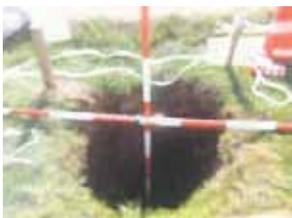
写真-1 陥没発生状況
