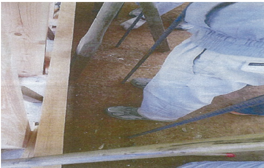
写真5-4-2 内部鉄筋補強を想定した施工状況
