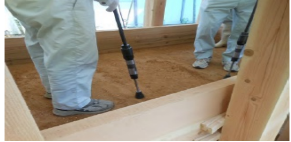
写真5-4-3 手持ちサンドランマー施工状況
