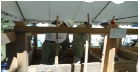
写真5-4-1 版築搗き作業状況
