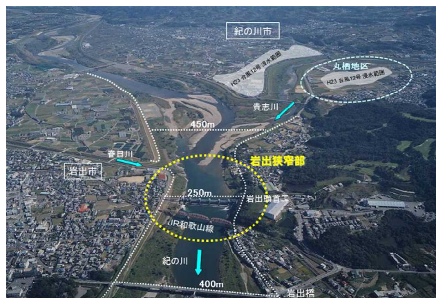
写真-1 紀の川 岩出狭窄部
