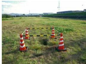
写真-3 陥没箇所a発見時
