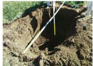
写真-6 陥没箇所b試掘状況
