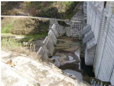
図-8 益田川ダムのスリットダムとゲートのスクリーン
