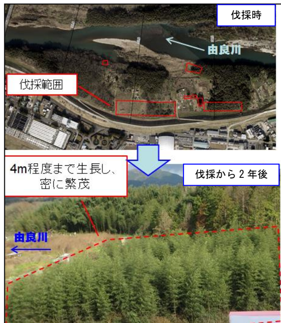
図-3 河道内樹木の再繁茂状況
