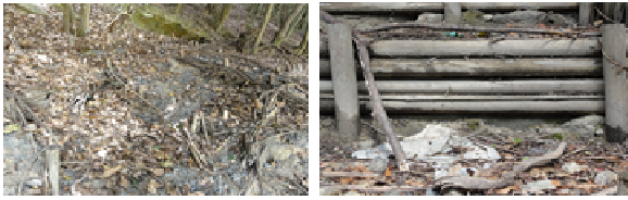
土壌侵食状況（柳枝が破損） 木柵基礎端部土砂の流出状況
