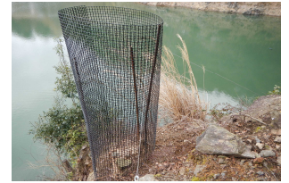
写真－８ 金網柵工の代替（ミキガード）
