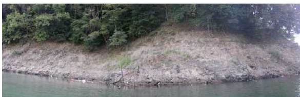
写真-1 湖岸裸地化の状況 右岸0.18km付近
