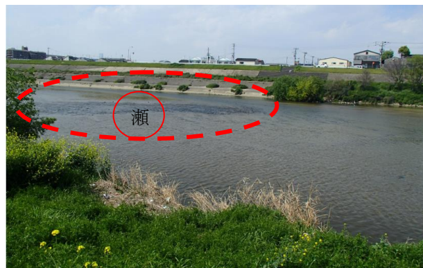
写真-4 11.0k瀬淵現地写真（H28.04.19左岸より撮影）
