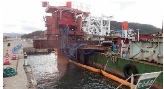
写真-10 コンクリートウェル基礎撤去状況
