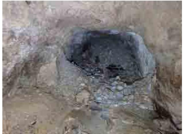
写真-11 対策工 D 区間の内部状況 (空洞かつ滞水なし)
