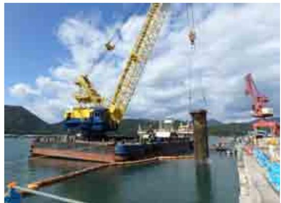
写真-9 コンクリートウェル撤去状況
