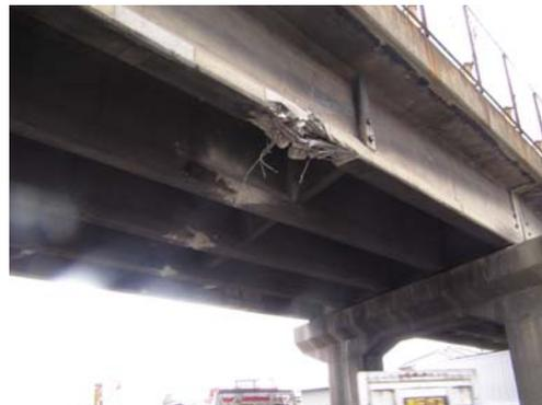
図-2 主桁の損傷
