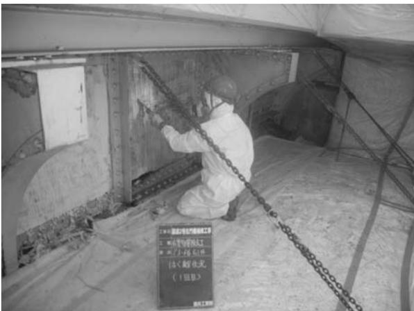
写真-7 左門橋 作業状況 (剥離1回目)
