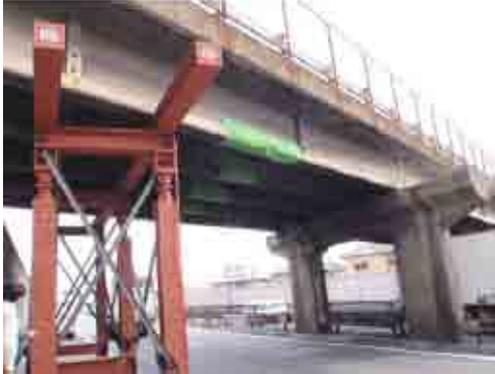
図-3 架設支保工の設置状況
