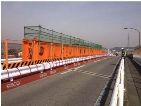
図-4 補強桁の設置状況
