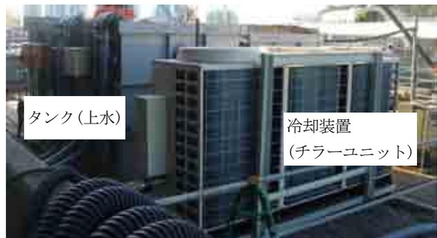
図-15 循環水冷却装置
