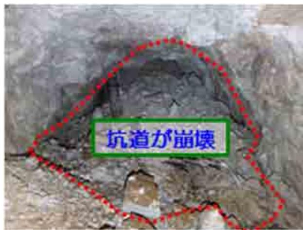
写真-10 坑道の崩壊状況 (対策工Dの先が埋まっている)
