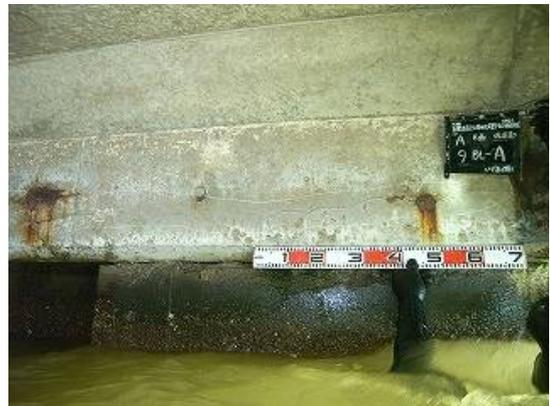
写真-4 ひび割れ及び錆汁状況
