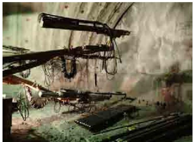
写真-6 対策工Aの施工状況 (鋼管打設)
