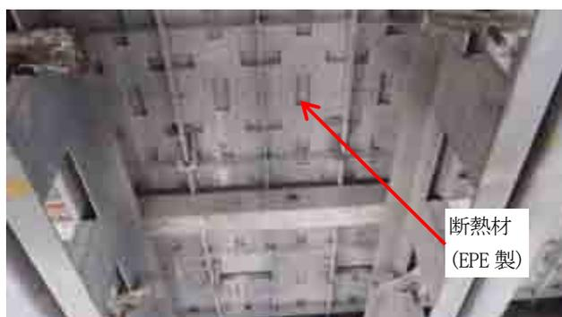
図-17 保温型枠設置状況
