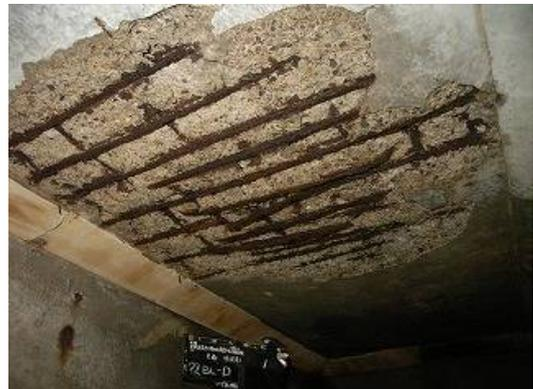
写真-5 床版裏剥離・鉄筋腐食
