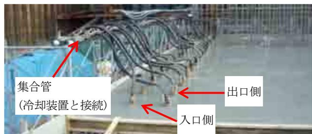
図-16 クーリングパイプ通水状況
