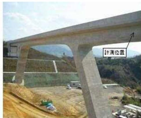
写真-3 実橋のひずみ計測位置
