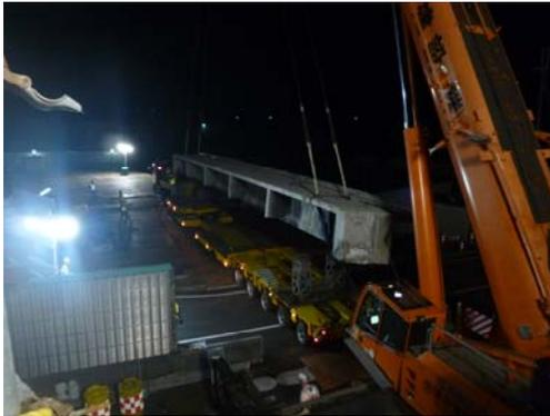
図-15 既設橋主桁撤去の状況
