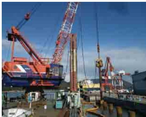
写真-11 鋼矢板打設状況
