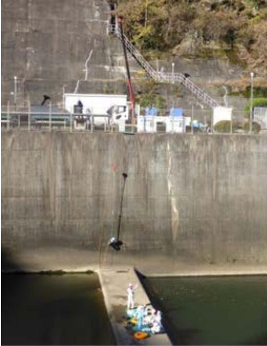
写真-2 減勢池の越流堤と機材搬入
