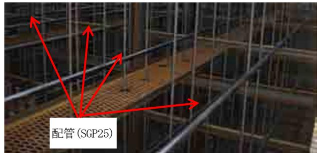
図-14 クーリングパイプ配管状況
