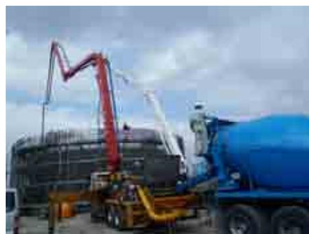
写真-5 コンクリート打設
