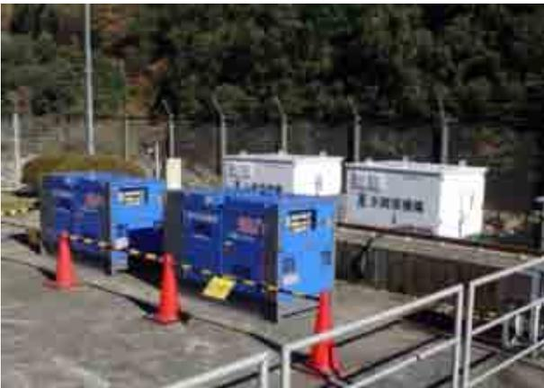
写真-3 操作制御盤・発電機設置
