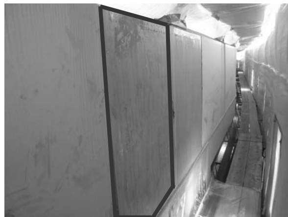
写真4 浜手バイパス バイオハクリX試験施工状況 （塗布後24時間以上経過）
