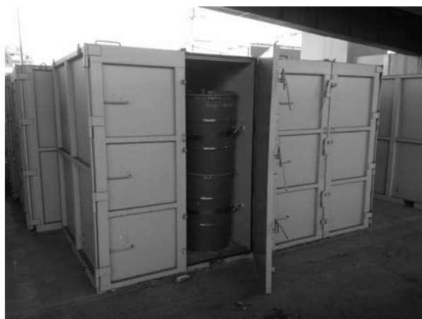
写真-10 PCB保管状況
