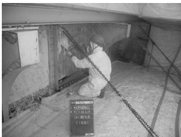
写真-7 左門橋 作業状況（剥離1回目）
