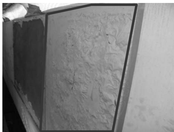
写真5 浜手バイパス MSハクリ試験施工状況 （塗布後40分経過）
