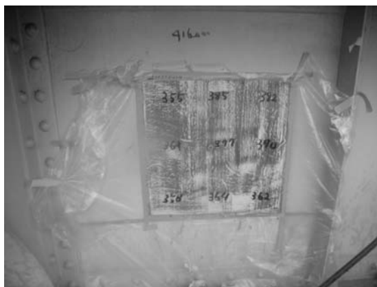
写真3 左門橋 バイオハクリX 試験施工（1回目剥離）
