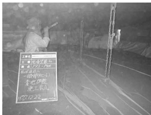
写真-8 浜手バイパス 作業状況（ブラスト処理）
