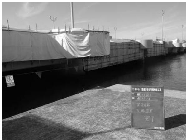
写真-6 左門橋 仮設置状況
