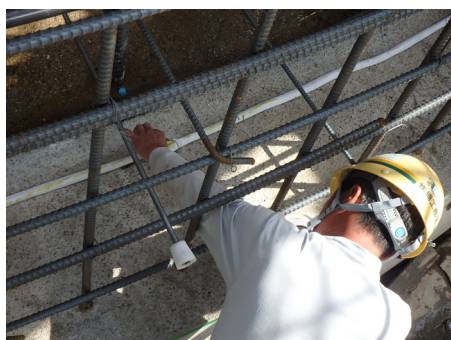
写真-14 ポリニットロープ施工状況
