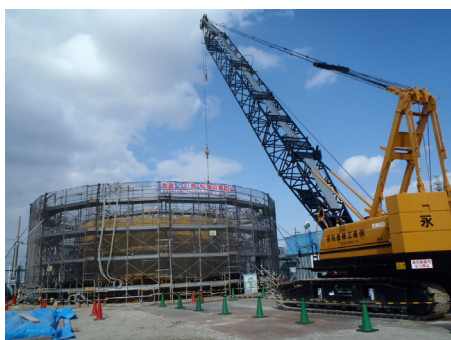
写真-3 足場・型枠組立
