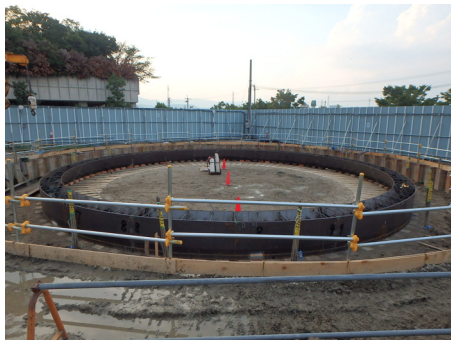
写真-2 刃口金物据付
