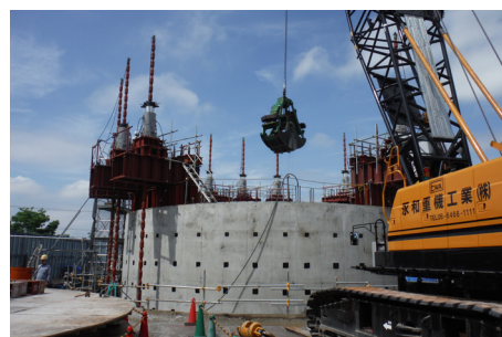
写真-6 掘削・沈下
