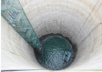
写真-7 壁面清掃
