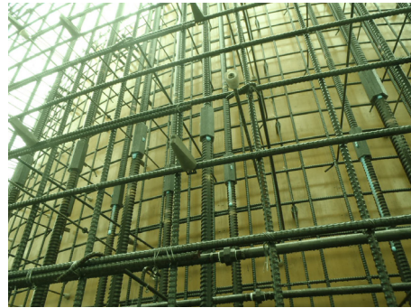
写真-4 鉄筋組立
