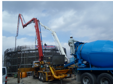
写真-5 コンクリート打設
