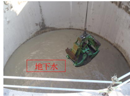
写真-9 オープンケーソン工法
