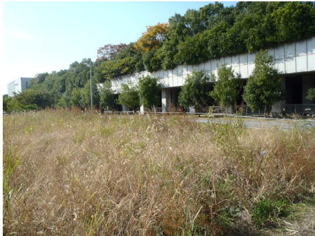
写真-1 発進立坑の施工場所
