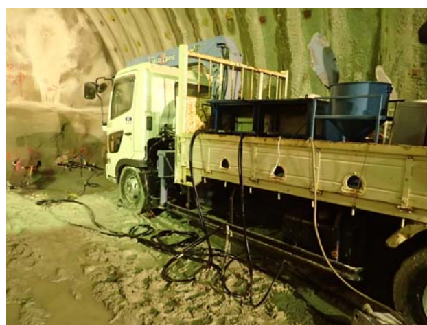
写真-9 発泡ウレタン注入の状況
