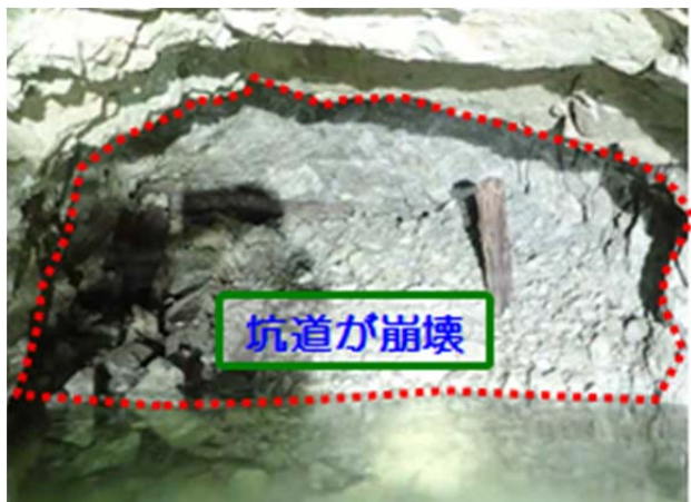
写真-8 坑道の崩壊状況 (対策工Aの先が埋まっている)
