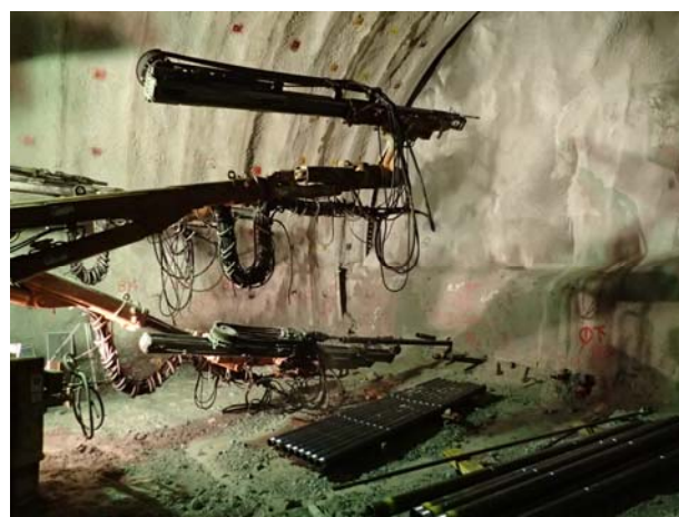
写真-6 対策工Aの施工状況 (鋼管打設)
