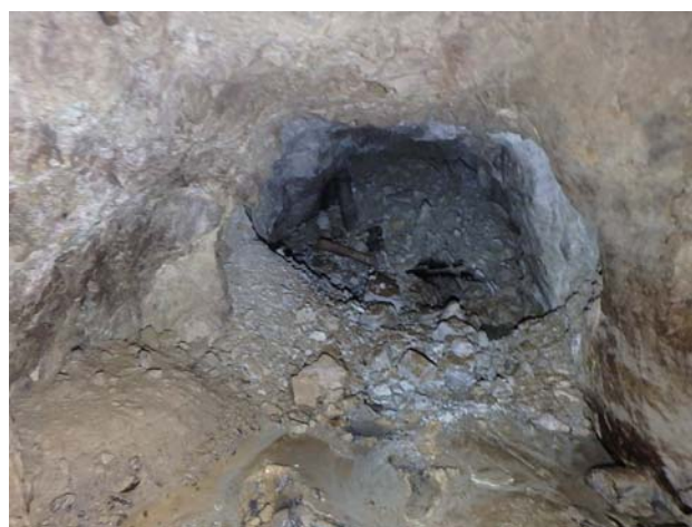
写真-11 対策工D区間の内部状況（空洞かつ滞水なし）
