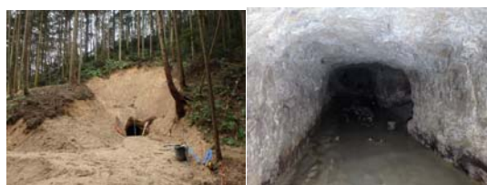
写真-1.2 廃坑坑口及び内部（水泥トンネル起点側）
