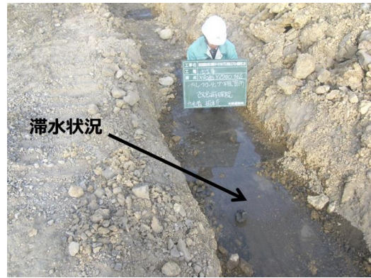
図-13 路床面下部滞水状況
