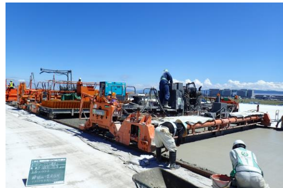
図-18 コンクリート打設状況
