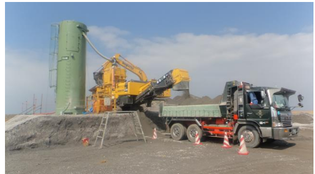
図-14 移動式プラントによる製造状況
