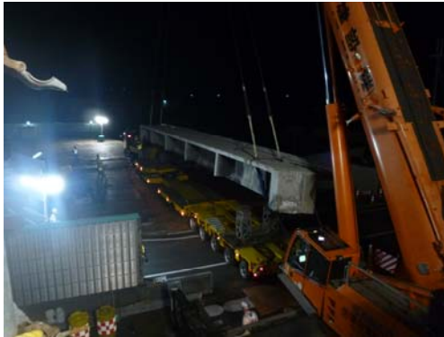
図-15 既設橋主桁撤去の状況
