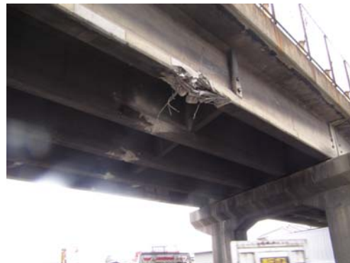
図-2 主桁の損傷
