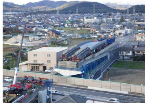
図-16 架設前の状況
