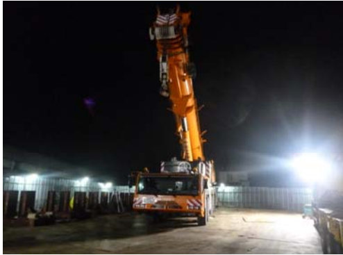
図-14 360 t吊りラフテレーンクレーン
