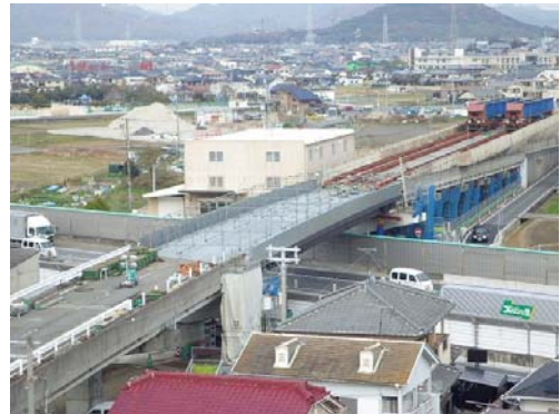
図-18 架設後の状況
