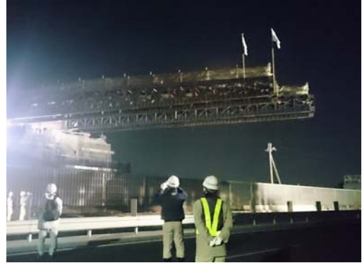
図-17 送り出し架設の状況
