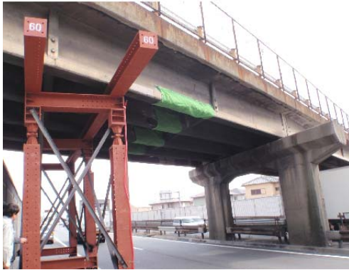
図-3 架設支保工の設置状況
