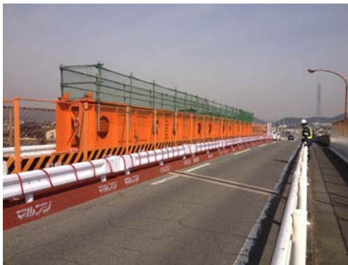
図-4 補強桁の設置状況
