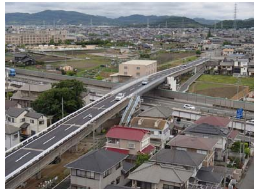
図-19 供用後の状況
