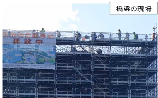
図-3 工事安全連絡会での合同パトロール
