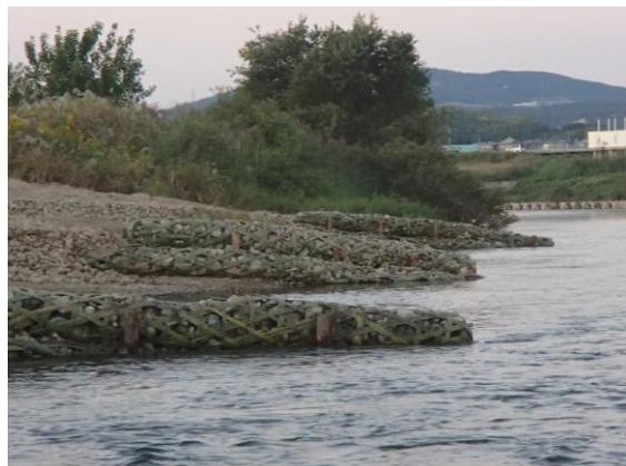
図-4 竹蛇籠水制設置後の様子。写真手前から奥にかけて3セットの竹蛇籠を設置した。
