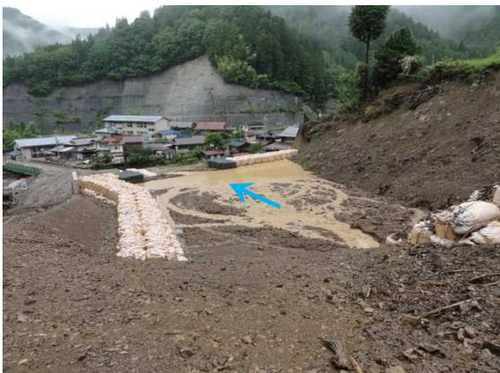
写真-2 仮堰堤位置での浸食状況
