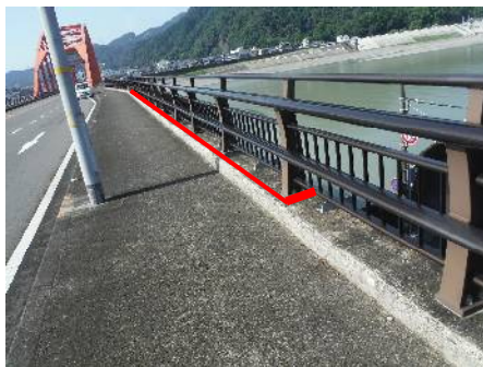
写真-3 仮設電気設置位置
