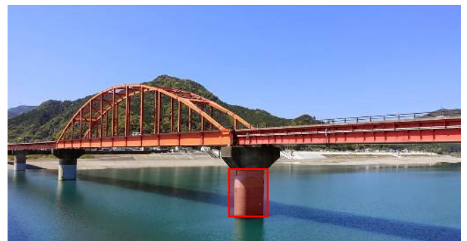
写真-1 新熊野大橋P4橋脚
