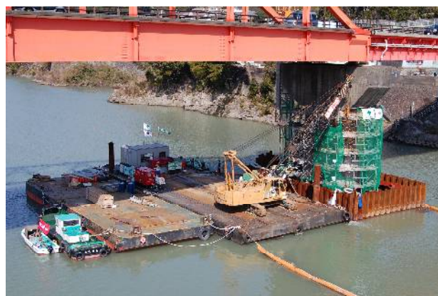
写真-6 施工状況
