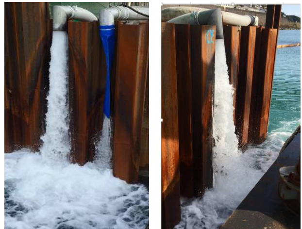
写真-5 水替え工（接写）
