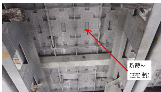
図-17 保温型枠設置状況
