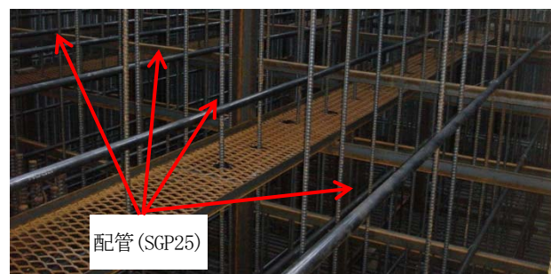
図-14 クーリングパイプ配管状況
