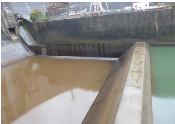
写真-7 排水作業完了
