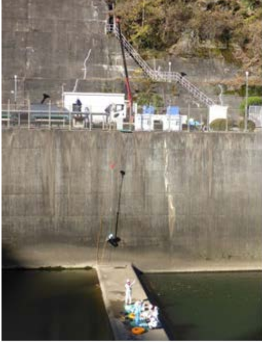
写真-2 減勢池の越流堤と機材搬入
