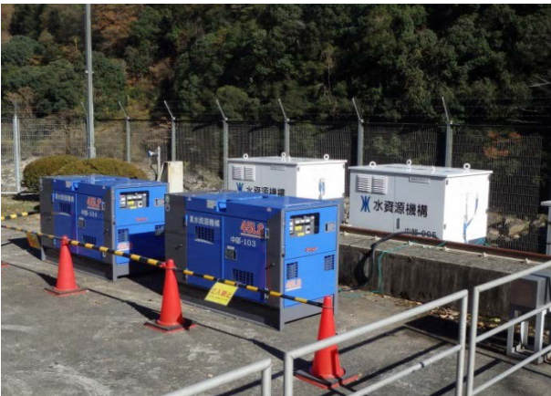
写真-3 操作制御盤・発電機設置 ポンプ本体は減勢池水面の低下に伴い隣り合うポンプ
