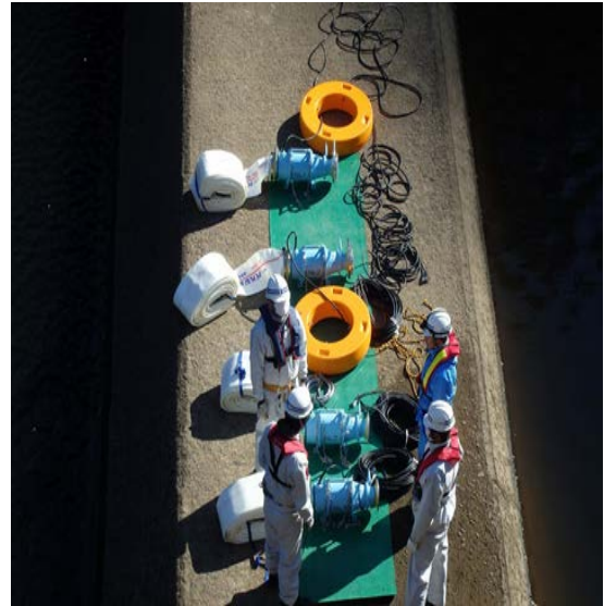
写真-4 排水ポンプ組立完了
