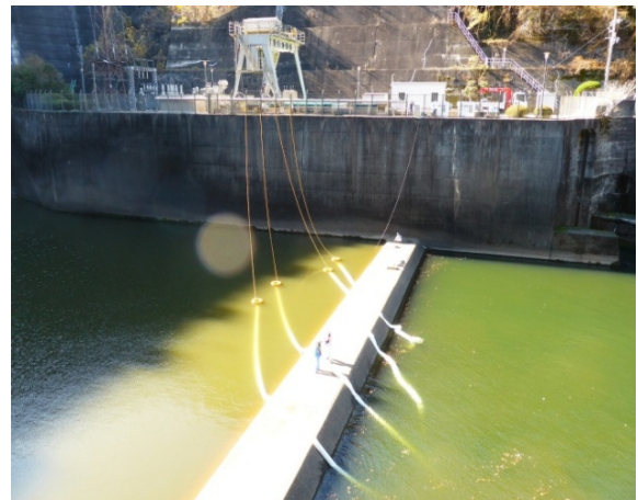
写真-5 ポンプ運転
