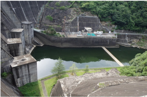
写真-1 高山ダム減勢池
