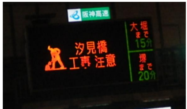
図-2 道路情報板文字欠け状態
