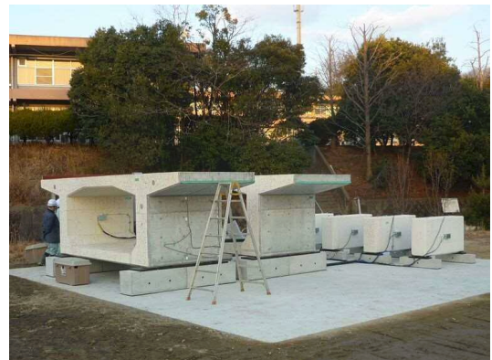
写真-1 供試体設置状況(近畿技術事務所)
