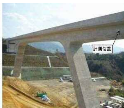
写真-3 実橋のひずみ計測位置
