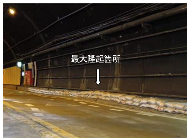
写真-1 隆起している路面
