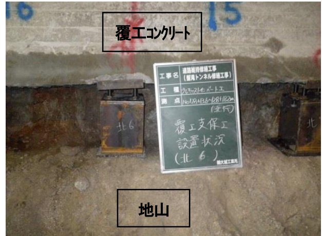
写真-4 支保工設置状況
