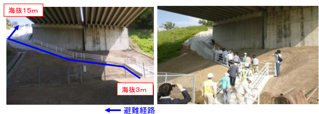
写真-6 津波避難階段
