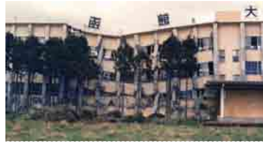
1階は全面破壊・中央部の柱は全階で破壊 写真-10 函館大学校舎の破壊例 26) (1968)
