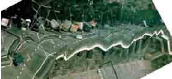
(西) (縦向きを横に図示) (東) 写真-5 倒壊区間の航空写真 21)
