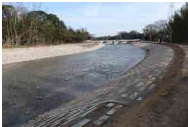
図-18 工事完成（中道橋より上流を望む）
