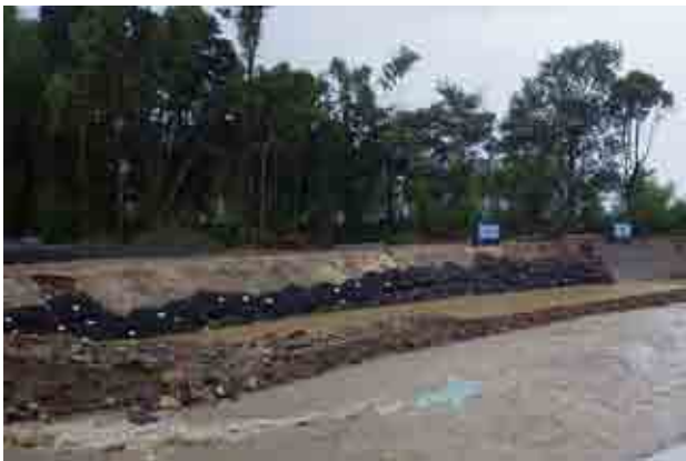
図-17 台風11号対策状況（大型土のう）
