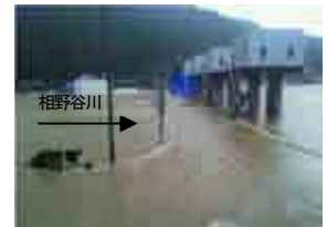
写真-2 鮎田水門付近の状況
