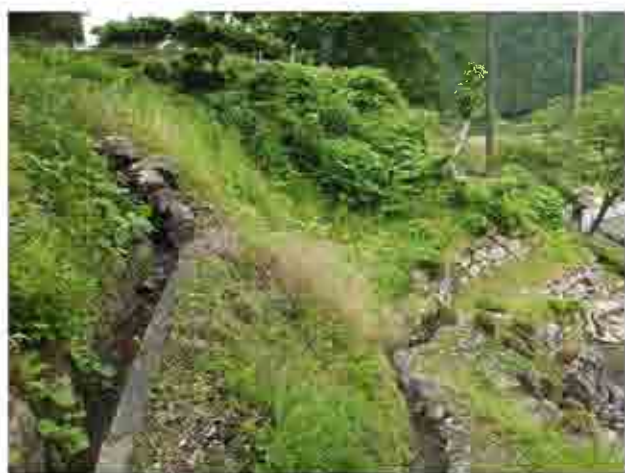
写真-3 崩壊斜面修復後約5年経過した状況（側面）
