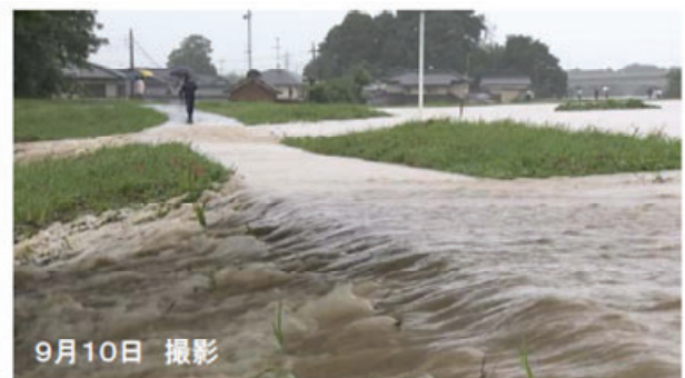
写真-1 12:10頃の越流状況 1)
