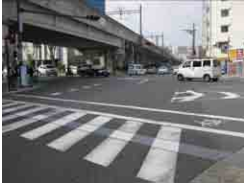
図-6 施工前 (交差点部)
