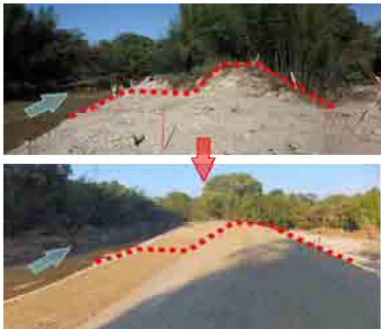
図-12 破堤箇所復旧断面および施工状況
