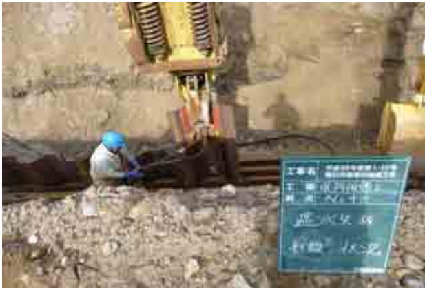
図-16 現地施工状況（遮水矢板打設）
