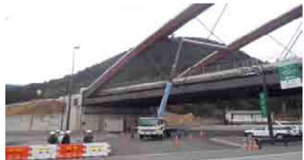
写真-7 チェーン着脱所を利用した現場検証
