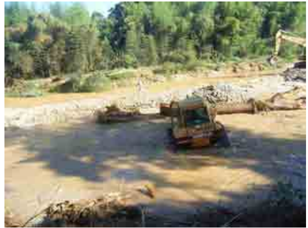
図-13 応急復旧2日目の施工状況
