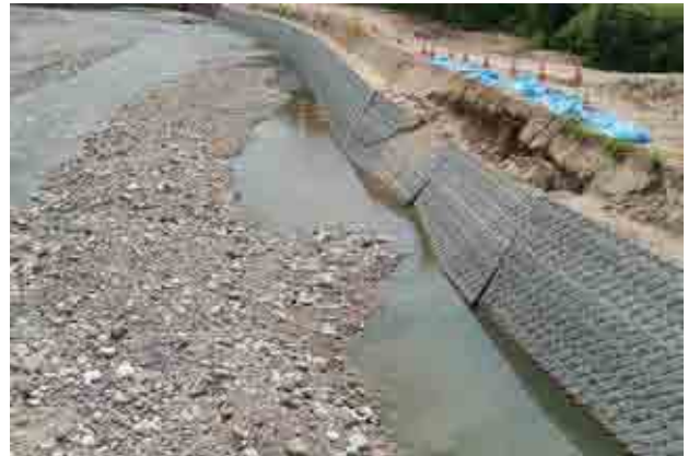
図-19 施工済区間における被災状況
