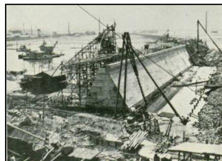
図-2 防潮堤建設状況
