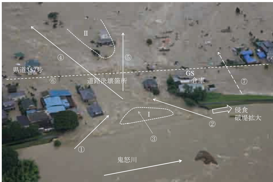
写真-2 15:18の破堤状況：国土交通省関東地方整備局の提供／追記は著者による
