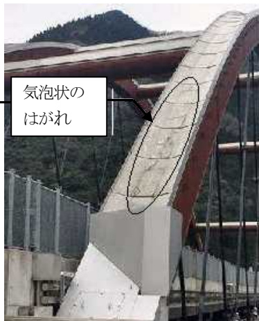
写真-5 アーチリブのフィルムの損傷
