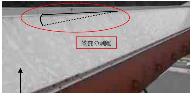
写真-4 落雪した箇所（剥離が発生）
