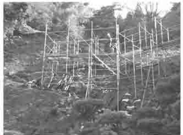
図-5 木杭工事足場の状況 1)
