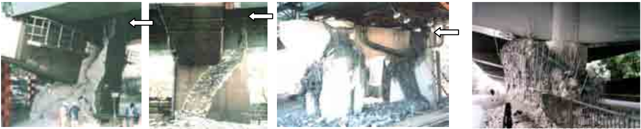
(a) 神P150 (b) 神P240 (c) 神P688 写真-3 T型と門型橋脚の裸鉄筋の直立 (矢印部に直立裸鉄筋) 7,8)
