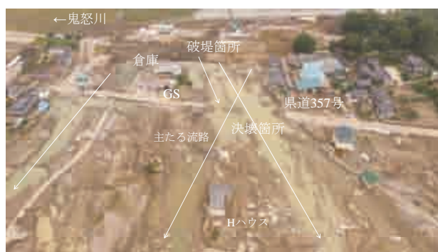
写真-3 堤内地の落堀：関東地方整備局の提供／追記は著者
