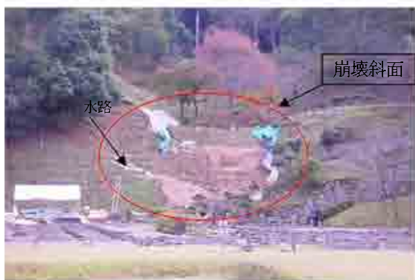
写真 1 斜面の崩壊
