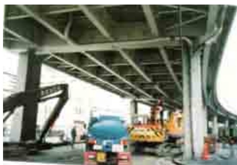
写真-1 独立二本柱橋脚の代表構造 1)
