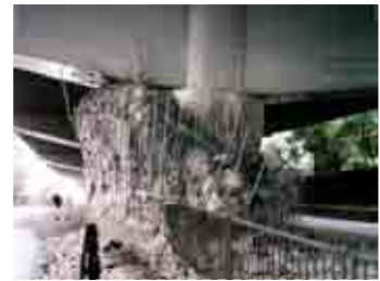
T型橋脚・神P57 写真-4 柱の圧縮破壊 7,8)
