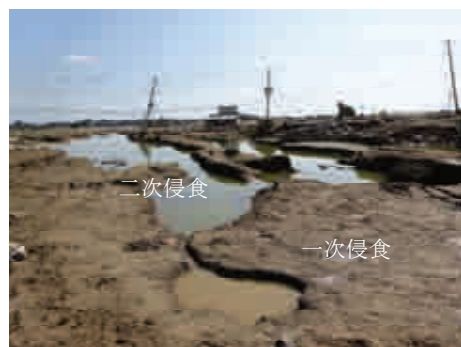
写真-4 堤内地に形成された落堀：9月26日
