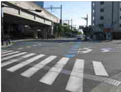
図-7 施工後 (交差点部)
