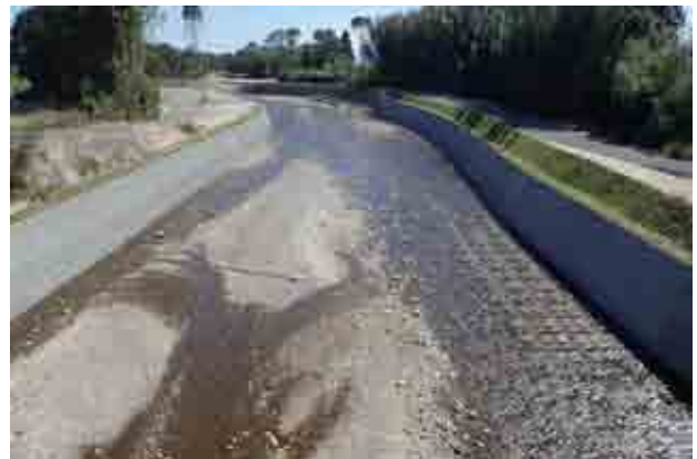
図-20 工事完成（行司橋より下流を望む）
