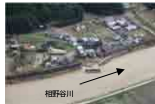
写真-3 高岡輪中堤の転倒
