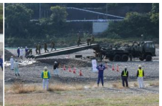
写真-10 自走式架柱橋による橋梁復旧
