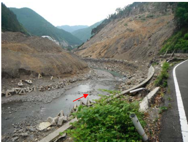
写真-3 河道閉塞解消後の状況
