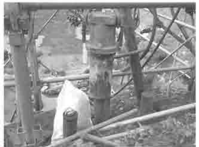
図-6 エア-杭打ち機の状況 1)
