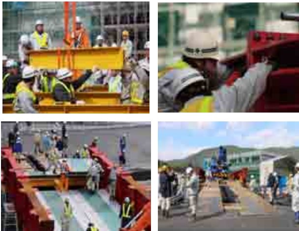
写真-13 緊急仮設橋組立訓練
