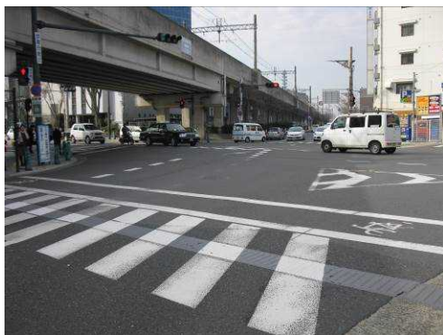
図-6 施工前（交差点部）
