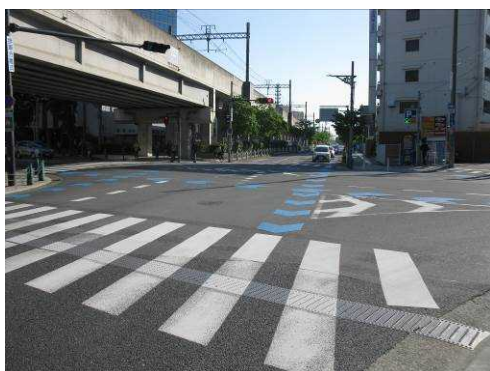
図-7 施工後（交差点部）
