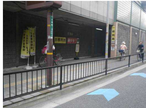
図-14 駐輪施設の出入口
