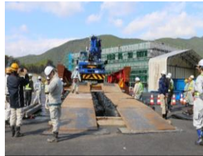
写真-13 緊急仮設橋組立訓練
