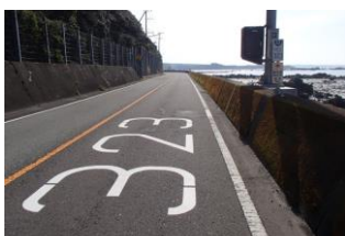
写真-7 国道 42 号(串本町田子)
