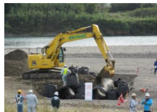
写真-9 コルゲート管等による橋梁復旧
