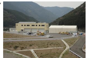
写真-5 すさみ防災基地
