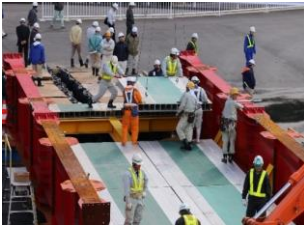
写真-13 緊急仮設橋組立訓練
