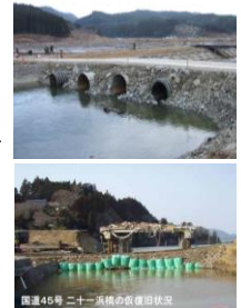
写真-3 緊急復旧のイメージ
