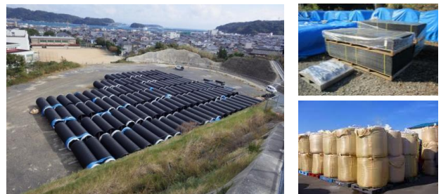
写真-4 コルゲート管、大型土のう、敷板の配備状況
