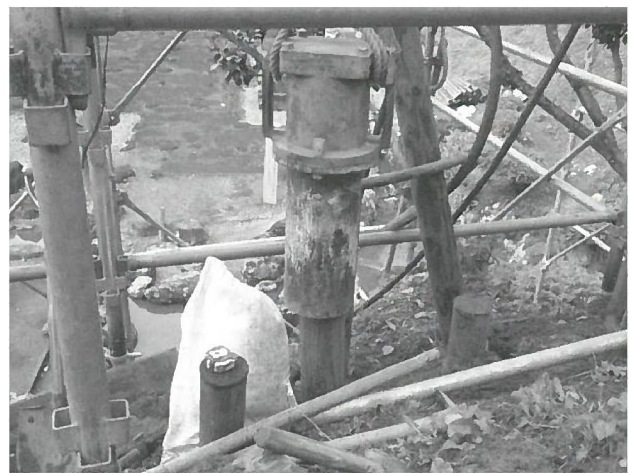
図-6 エア-杭打ち機の状況 1)
