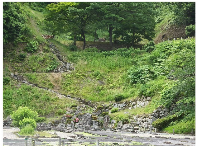
写真-2 崩壊斜面修復後約5年経過した状況(正面)
