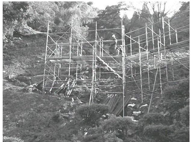
図-5 木杭工事足場の状況 1)
