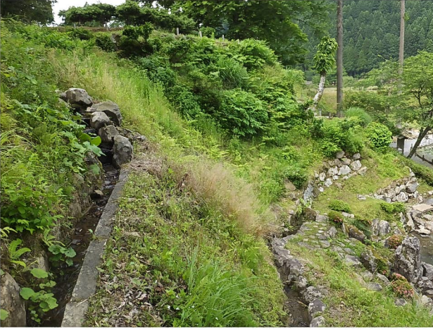
写真-3 崩壊斜面修復後約5年経過した状況（側面）
