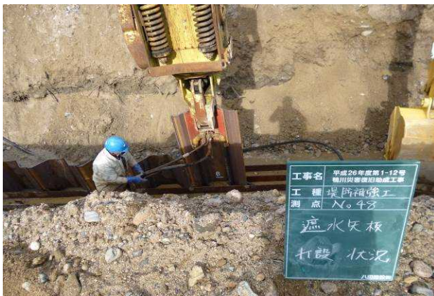
図－16 現地施工状況（遮水矢板打設）
