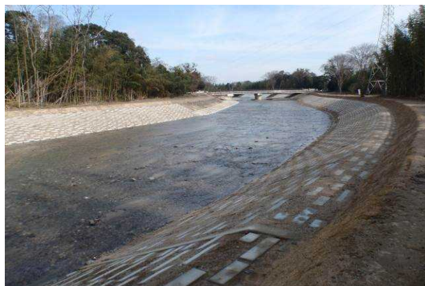
図－18 工事完成（中道橋より上流を望む）
