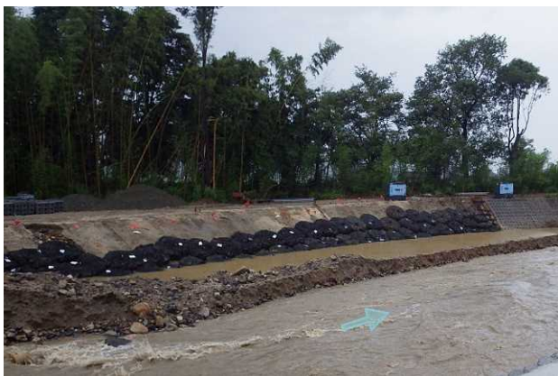
図－17 台風11号対策状況（大型土のう）
