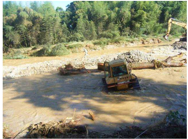
図-13 応急復旧2日目の施工状況
