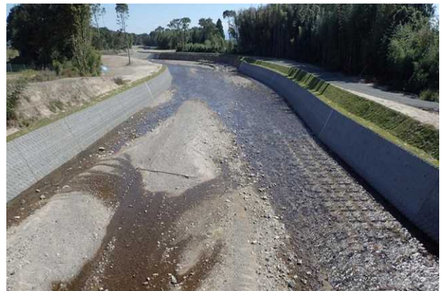
図－20 工事完成（行司橋より下流を望む）
