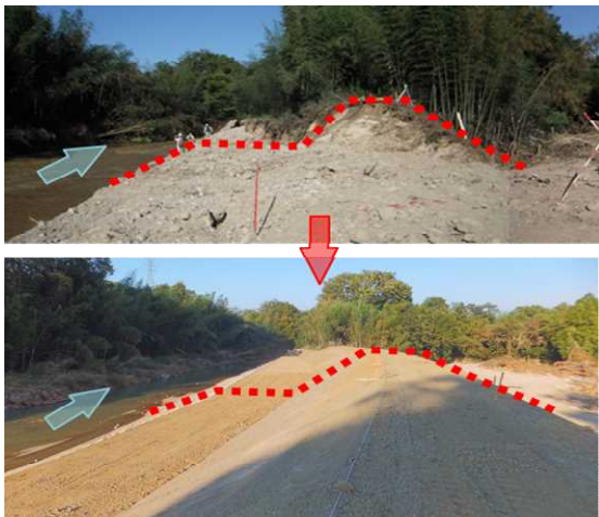
図-12 破堤箇所仮復旧断面および施工状況
