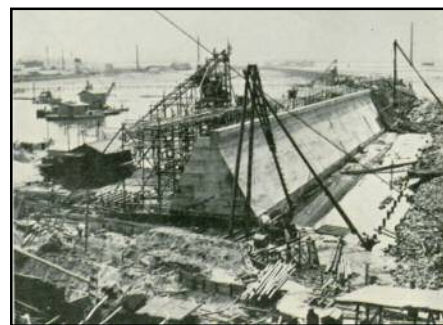
図-2 防潮堤建設状況
