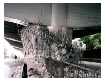
T型橋脚・神P57 写真-4 柱の圧縮破壊 7,8)
