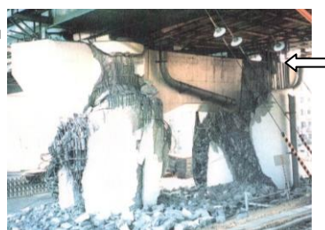
(a) 神 P150 (b) 神 P240 写真-3 T型と門型橋脚の裸鉄筋の直立(矢印部に直立裸鉄筋) 7,8)
