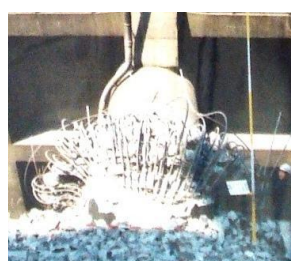
(a) 神 P133 (全周で提灯座屈) (b) 神 P136 (斜め全断面に分布) 写真-6 倒壊区間内での軸圧縮破壊の痕跡 3,4) (↑白破線付記)
