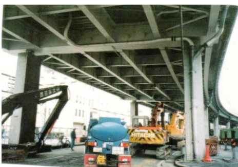
写真-1 独立二本柱橋脚の代表構造 1)
