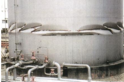
写真-9 タンクのダイヤモンド座屈 25)
