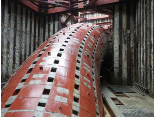
写真-13 管路全体
