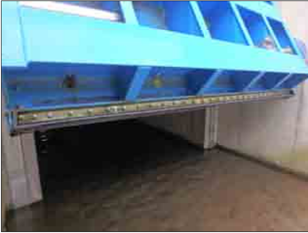
写真-8 L型水密ゴムの全閉前状況 ゴムのめくれや破断はなし
