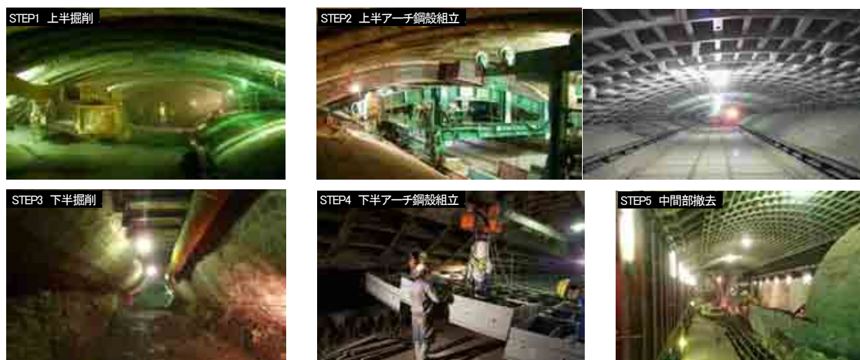
写真-1 施工状況
