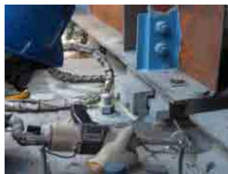
図-15 鋼製支承への施工
