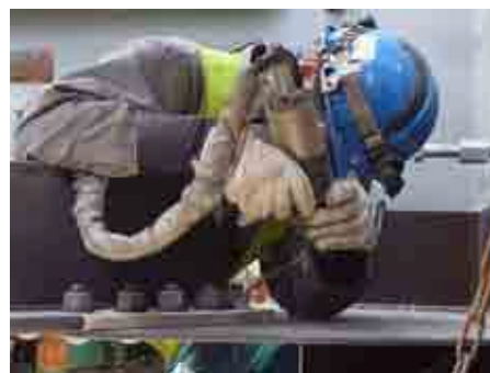
a) SZの施工状況
