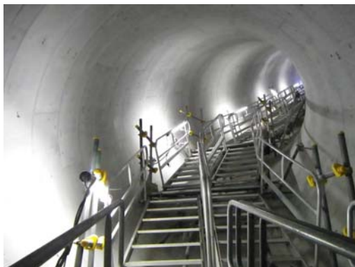
写真-15 管路内部
