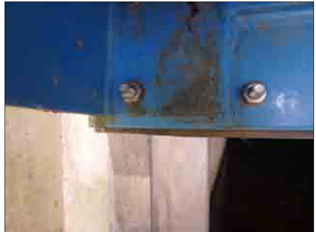
写真-6 水密ゴム写真（高剛性平ゴム）
