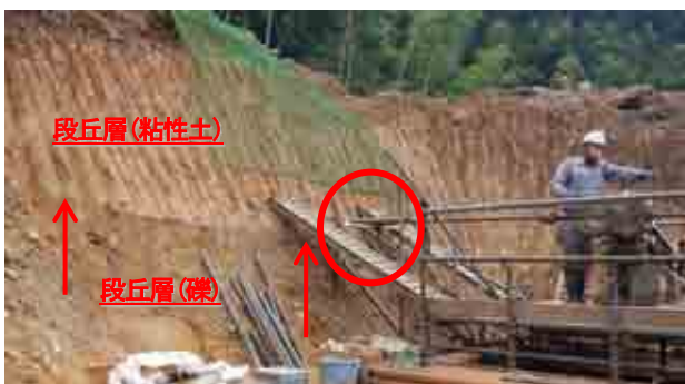
写真-2 坑口掘削のり面近景
