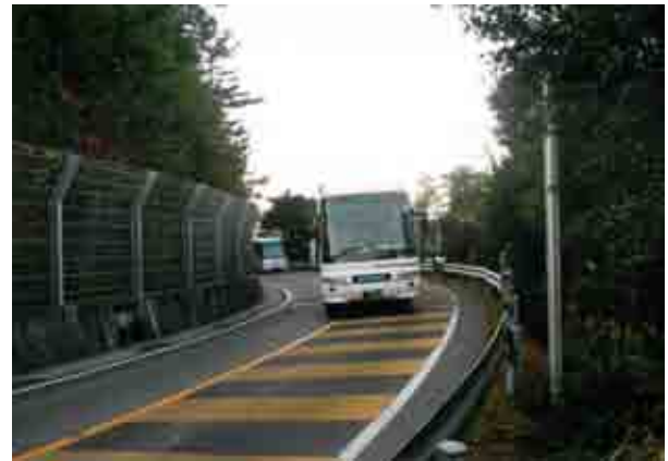
図-2 改良前の現道の状況
