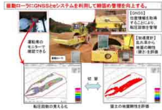
図-3-3 振動ローラ締固め管理
