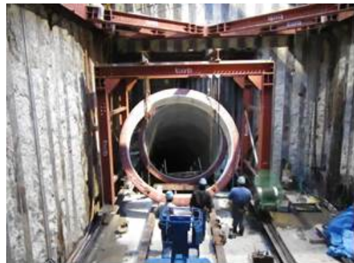
写真-12 立坑下横引き組立
