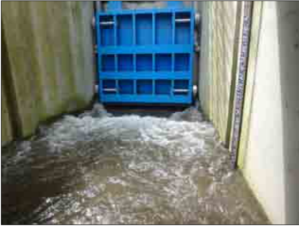
写真-14 フラップ時の流水状況（外水側）
