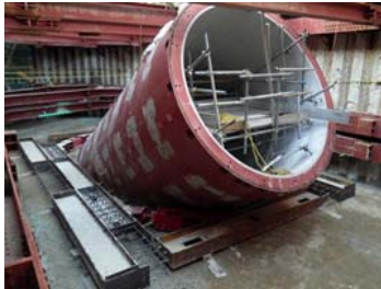
写真-2 開口補強材（SRC構造）
