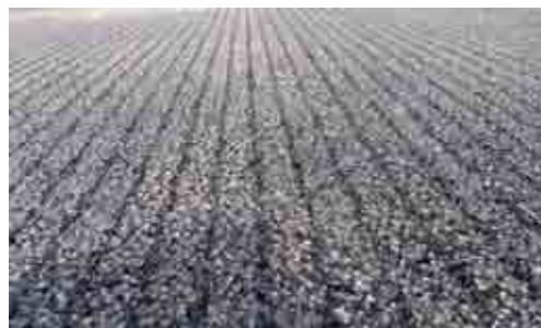
写真-2 縦溝粗面仕上げの例
