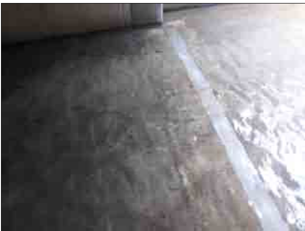
写真-16 フラップ後の堆積土砂状況
