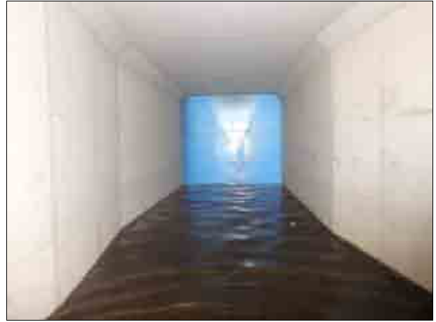
写真-11 樋門全閉状況（内水側）
