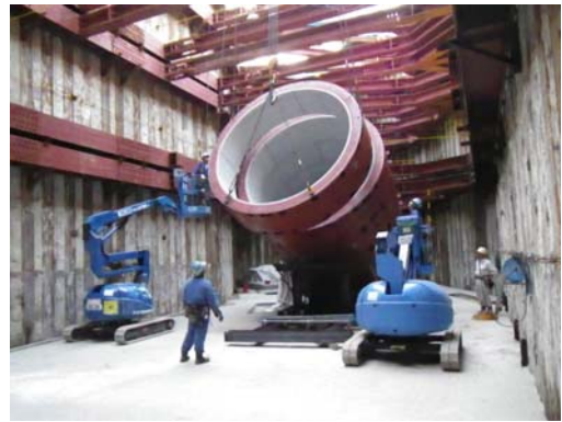
写真-10 組立状況
