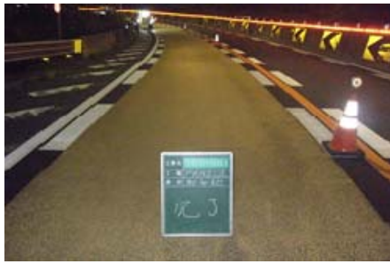
写真-4 すべり止め舗装の施工例
