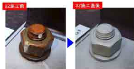
b) SZ施工前後のボルト
