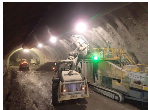
図-8 S-マックスシステム実施状況
