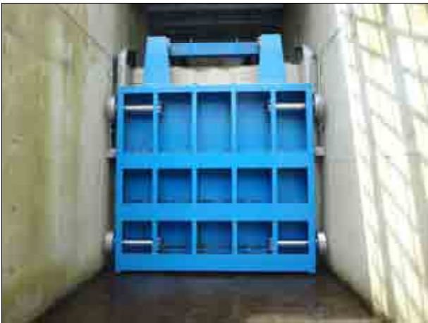
写真-10 樋門全閉状況（外水側）
