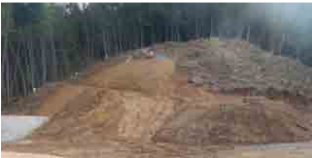
写真-1 坑口掘削のり面全景
