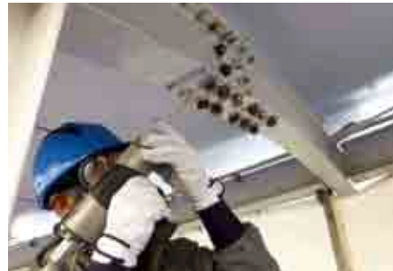
図-12 SZの施工状況
