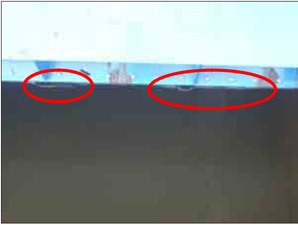
写真-3 水密ゴムの剪断状況
