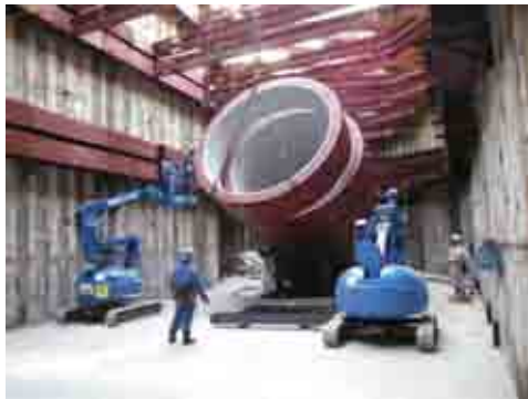
写真-5 SSPC外ボルト締結状況
