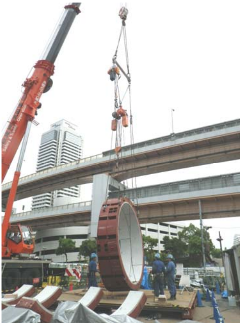
写真-9 SSPC投入状況
