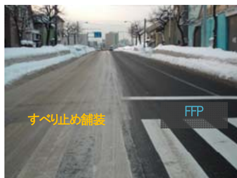
写真-8 路面露出状況
