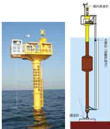
図-2 設置状況及び設置イメージ
