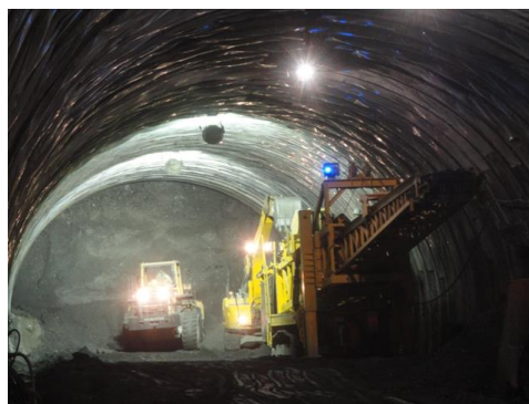
図-4 実証試験(移動式伸縮ベルトコンベヤ台車)
