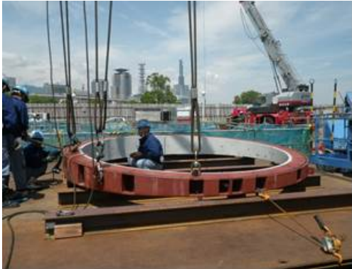
写真-8 SSPC地上組立状況 (R=4.5m用)
