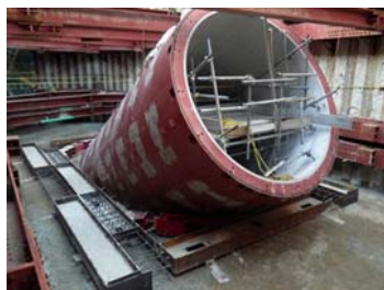
写真-2 開口補強材 (SRC構造)
