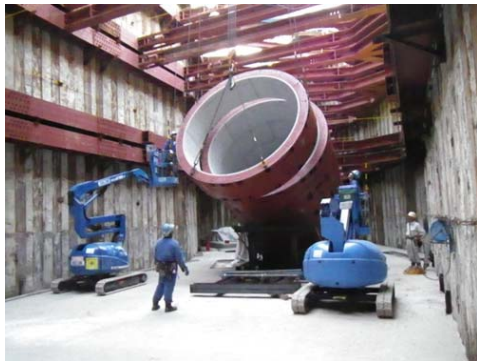
写真-5 SSPC外ボルト締結状況
