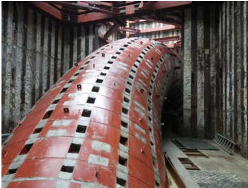
写真-13 管路全体
