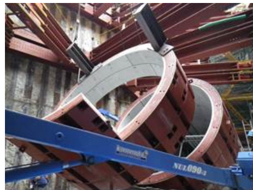
写真-11 SSPC組立(偏芯吊り)
