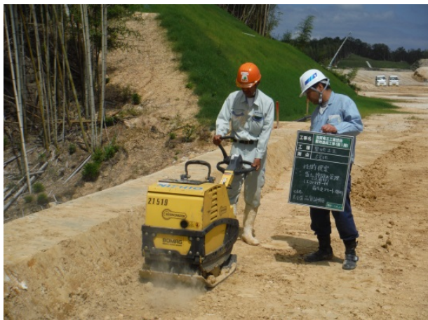
図-5 エコマイザ搭載コンパクトによる剛性確認状況
