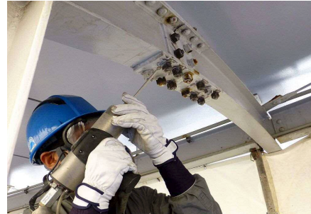
図-12 SZの施工状況
