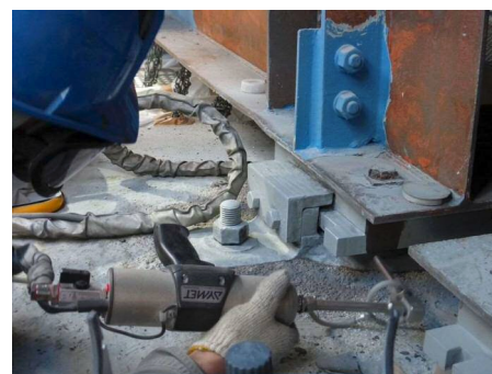
図-15 鋼製支承への施工
