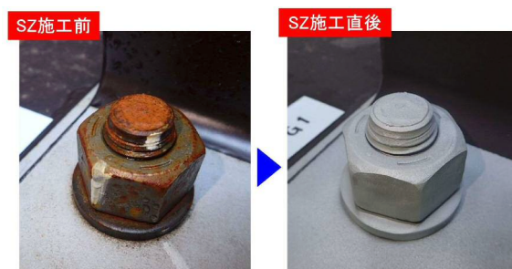
b) SZ施工前後のボルト
