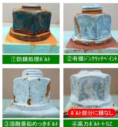
図-2 高力ボルトナット部の塩水噴霧試験結果 (1,512時間経過後)
