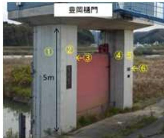
図5 門柱傾倒面計測位置
