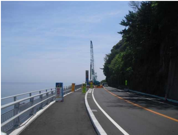
図-8 施工中の状況
