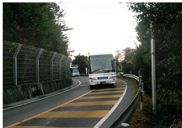
図-2 改良前の現道の状況
