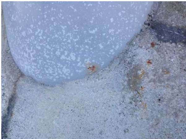
図-7 初期完成工区の鋼管基部の状況
