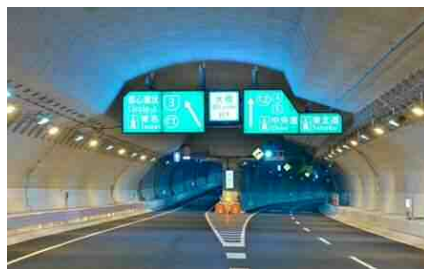
分岐部 (TYPE-C:本線・連絡路一体型)
