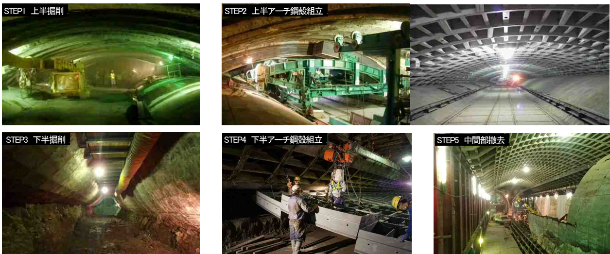
写真-1 施工状況
