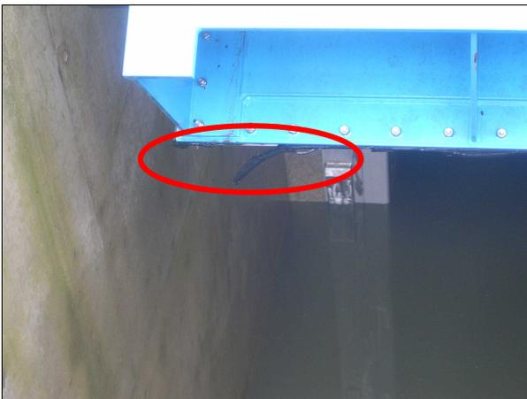
写真-4 水密ゴムの破断状況
