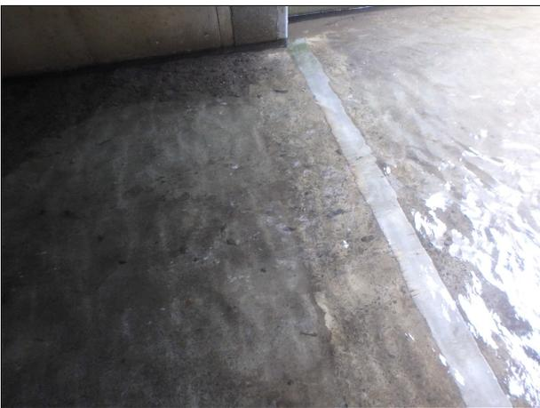
写真-16 フラップ後の堆積土砂状況
