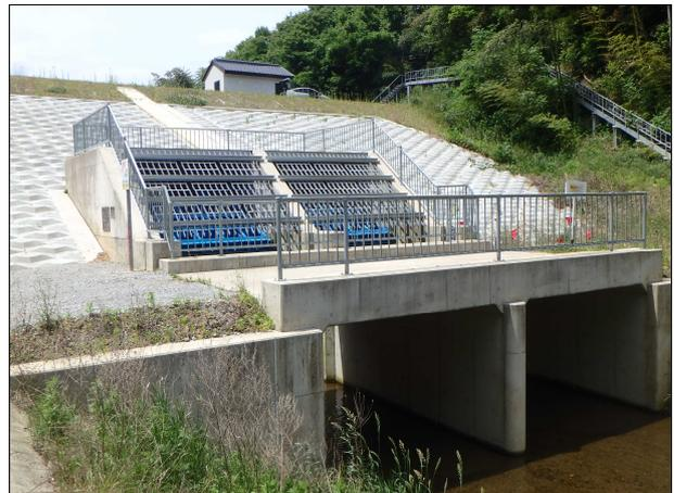
写真-2 引き上げ式門柱レスゲートの一般外観
