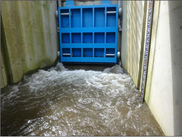
写真-14 フラップ時の流水状況 (外水側)
