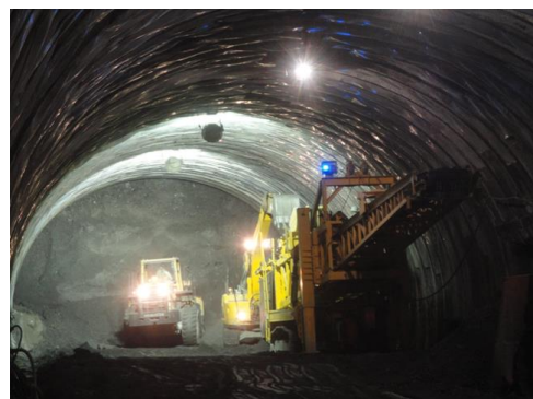
図-4 実証試験（移動式伸縮ベルトコンベヤ台車）
