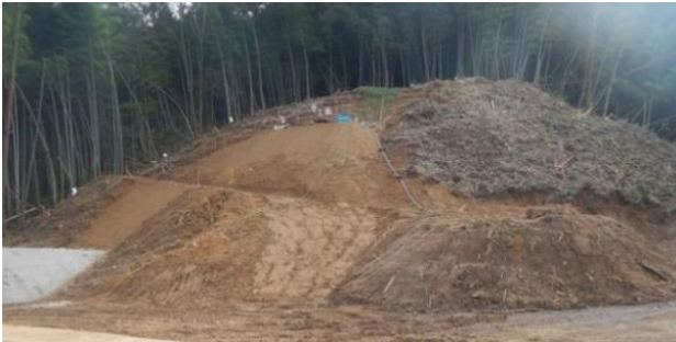
写真-1 坑口掘削のり面全景
