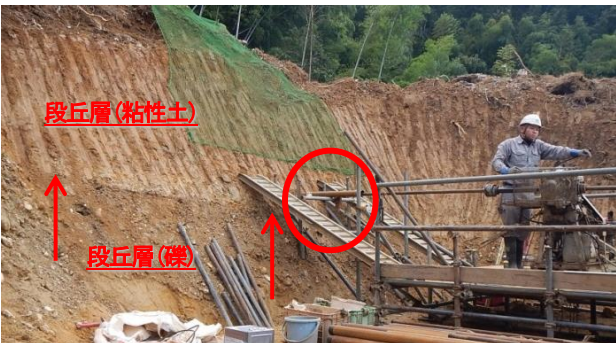
写真-2 坑口掘削のり面近景
