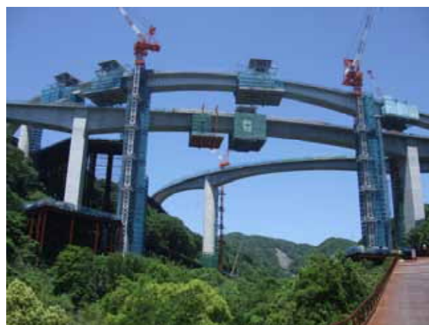
建設中の京奈和自動車道
