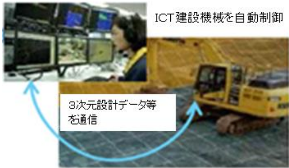
写真-5 ICT建設機械による施工
