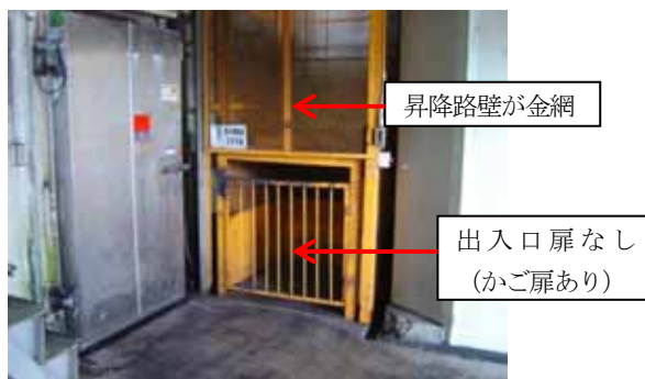
図-2 違法設置エレベーターの事例（コメントは安全に問題がある部分）
