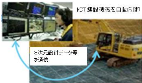
写真-5 ICT建設機械による施工
